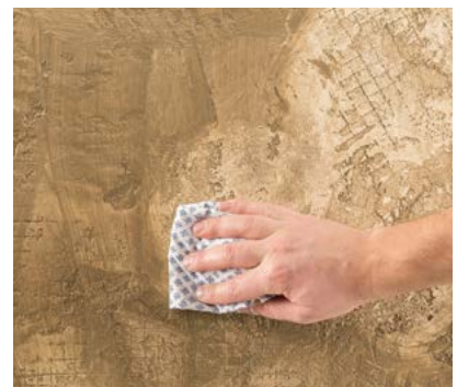
Überschüssige Seife mit einem Baumwollappen aufnehmen.
