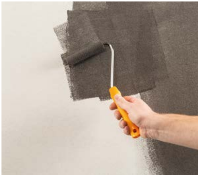
Grundfarbe in 2 Lagen mit 30% Wasser verdünnt auftragen.
