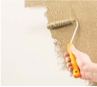
Eine Lage 928 Vesuvio mit 20% Wasser verdünnt auftragen.
