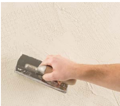
Die Fläche nach ca. 30 - 60 Minuten nochmals mit leichtem Druck glätten.
