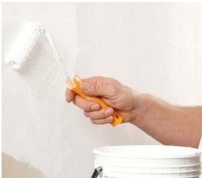
Grundieren der Fläche mit 309 Iso-Mineralgrund.
