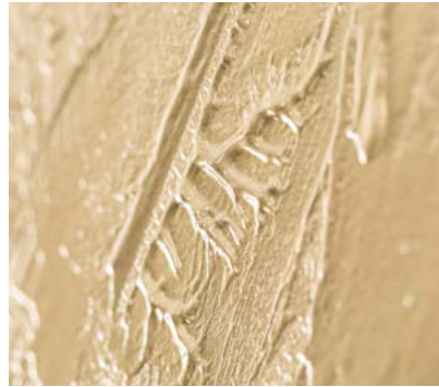
Zweite Lage großflächig mit der Glättkelle auftragen.
