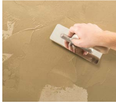
Zweite Lage großflächig mit der Glättkelle auftragen.
