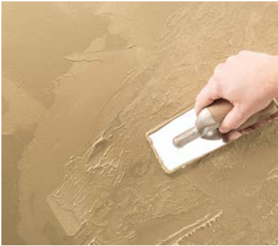
Oder die Fläche mit der Glättkelle je nach gewünschtem Effekt strukturieren.
