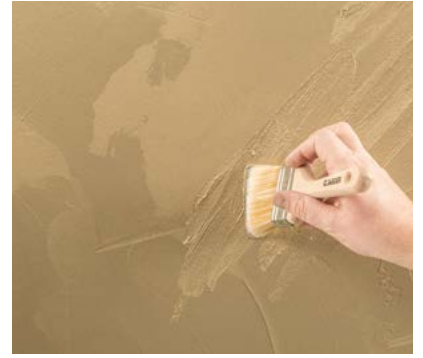
Die Fläche mit dem Pinsel je nach gewünschten Effekten strukturieren.
