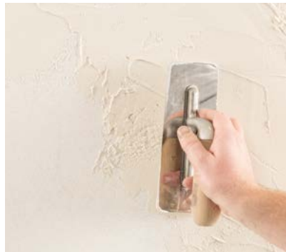
1. Lage 927 Calce Argilla auftragen.
